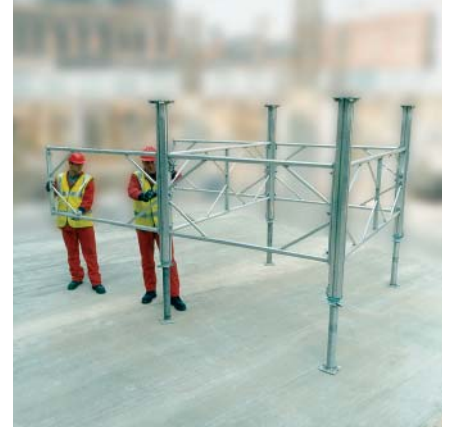
6. Seuraavaksi kiinnitä lisäkehät ja tuet muodostaen Mega Rami -tuentarakenteen.
