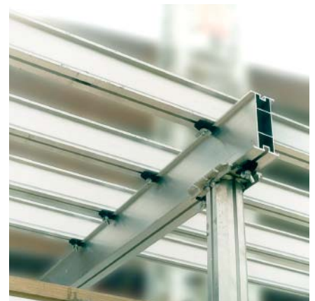
9. Aseta koolauspalkit ja kiinnitä koolauspalkit pikakiinnikkeillä niskapalkkiin. Rakenne on valmis vanereiden asennukseen.
