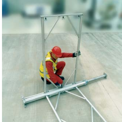
2. Kiinnitä kehä pystysuunnassa alumiinitukeen.
