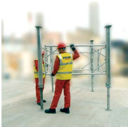
4. Toista kohta 1 asentaen neljäs kehä ja nosta tuennan sivut pystyasentoon.
