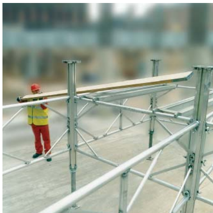
7. Asenna telinelankut ja telinelankkujen välituet kiinnittäaksesi alumiinipalkit.
