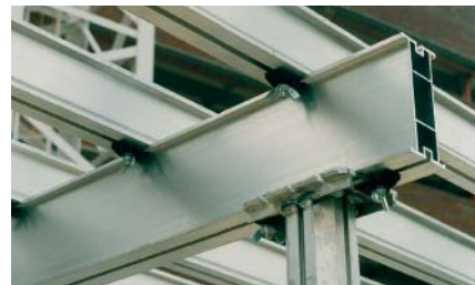
Alumiinipalkin kiinnittäminen päätylevyyn
