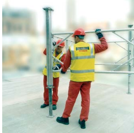
5. Kiinnitä tuennan sivut toisiinsa muodostaen nelijalkaisen tornin.
