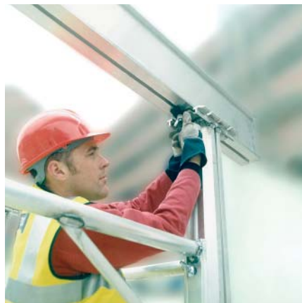
8. Kiinnitä niskapalkit päätylevyyn kahdella pikakiinnikkeellä.
