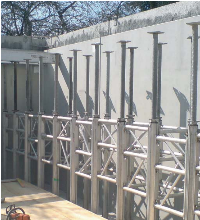
TITAN HV Lite Prop -tuki TITAN Ledger Frame -tukikehällä vakautettuna.
